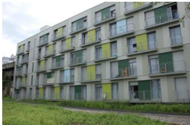
Les boîtes en bois sont fixées par des platines métalliques sur le béton de la structure existante.
