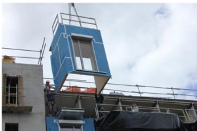
Assemblées sur place, les logettes équipées de leur menuiserie et du volet roulant
